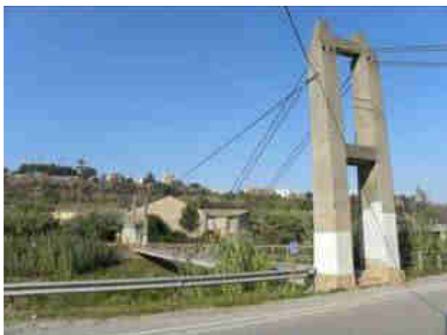
Pont del riu Ripoll
